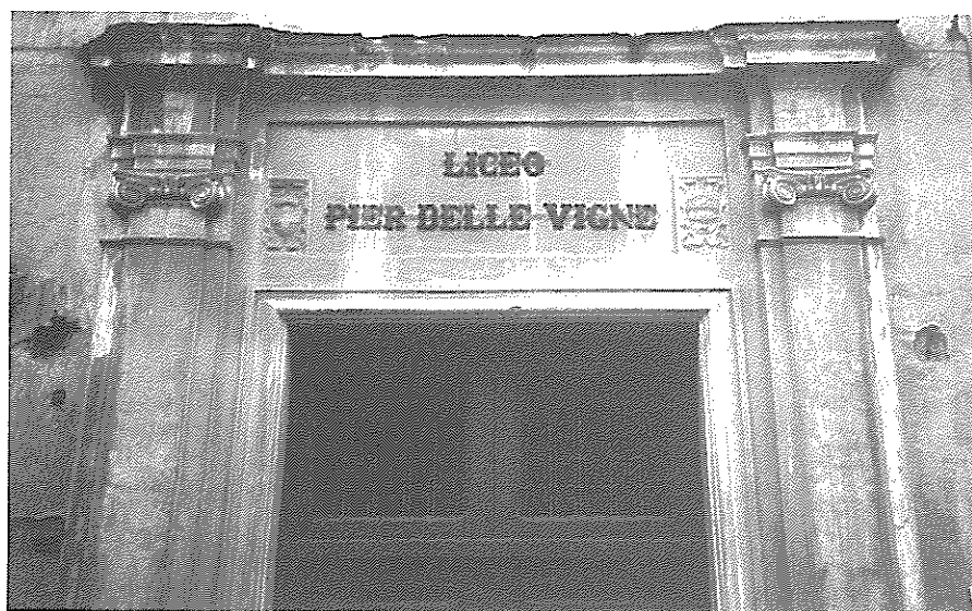
Fig. 14. Ingresso dell'ex Liceo "Pier Delle Vigne" in via Roma a Capua.
